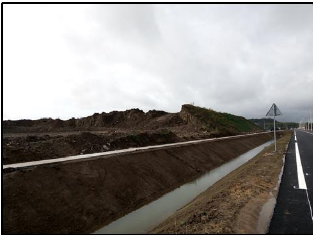
Photos 3 : site du projet (Rainette, 2019) (2/3)
